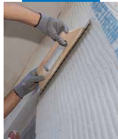
Indstøbning af Mapetherm Net armeringsnet
