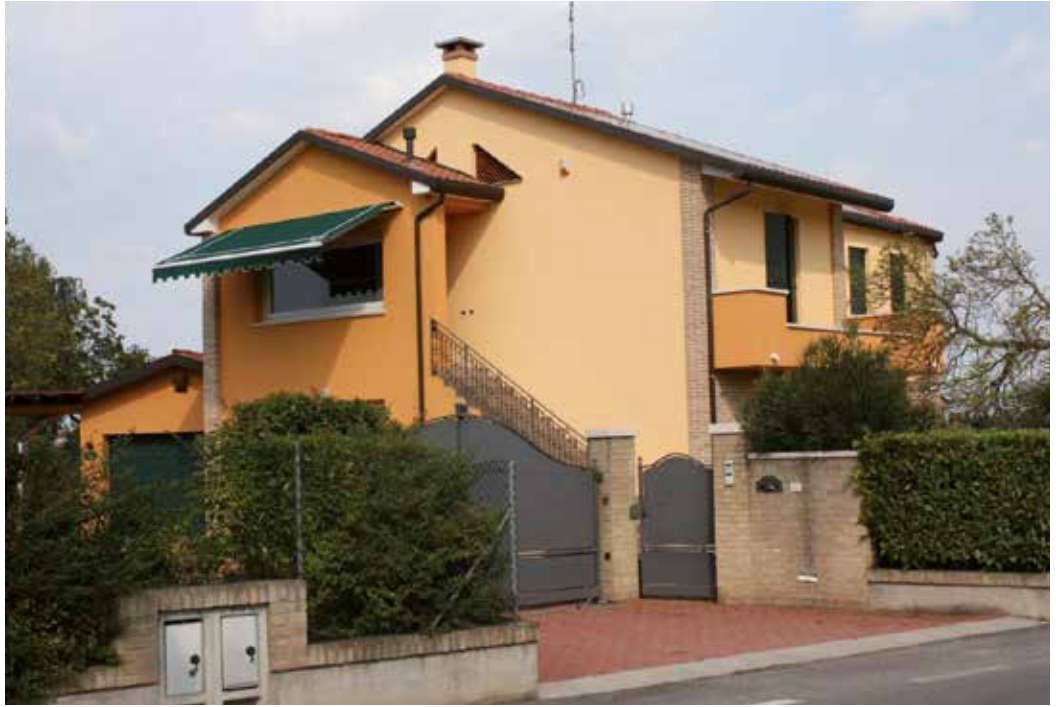
Her er Mapetherm AR1 Light brugt som klæbemiddel og som svummeblanding. Privat hus - Noale (Venedig) Italien
