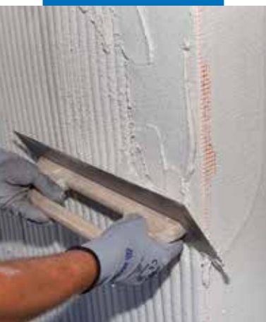
Påføring af det første svummelag af Mapetherm AR1 Light
